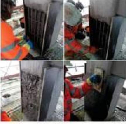
बैक्टीरिया आधारित स्व-उपचार मरम्मत मोर्टार के साथ क्षतिग्रस्त स्टील प्रबलित कंक्रीट कॉलम की साइट पर संरचनात्मक मरम्मत
