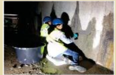
बैक्टीरिया-आधारित स्व-उपचार मरम्मत मोर्टारसेदरार वालीकंक्रीटबेसमेंट दीवारों की मरम्मत
