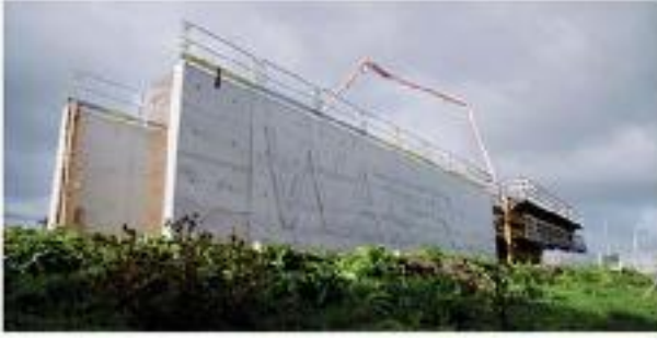
पूर्ण पैमाने पर प्रदर्शक इन-सीटूकास्ट सेल्फ-हीलिंग कंक्रीट जलाशय
